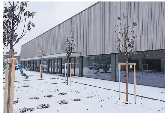
Die neue Halle passt sich gut in die bestehende Schulanlage ein.
